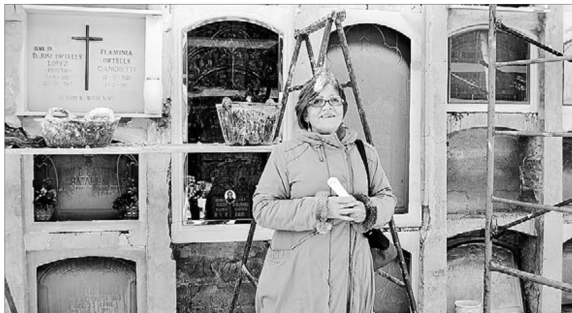
La edila de Cementerio, Rosario Royo, ha visitado las obras de mejora y recuperación de nichos.
