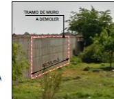
DEMOLICIÓN DE MURO EXISTENTE PARA CONEXIÓN CON CAUCE INAGRA ACTUAL.
